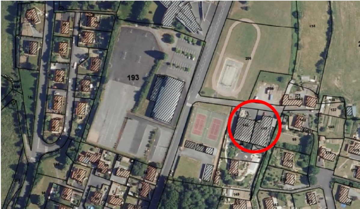
Local de stockage dans le bourg de Montrevault, à proximité du collège et au centre d'un quartier pavillonnaire
